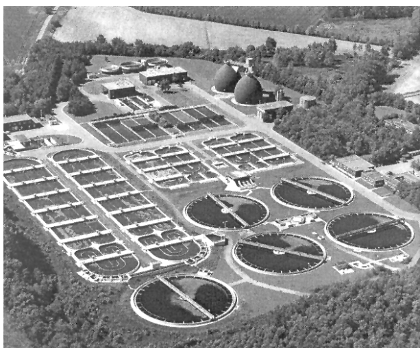
Slika 5. Sistem za prečišćavanje otpadnih voda u industriji celuloze i papira
